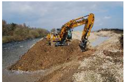
Abbildung 50. Donaurenaturierung Hundersingen-Binzwangen während der Baumaßnahmen (Foto: A. Schnellbacher-Bühler)
